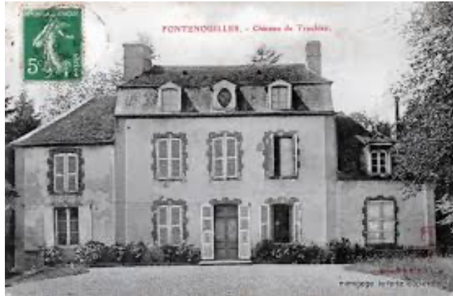
Château de Truchien, à Fontenouilles-Charny (89)
