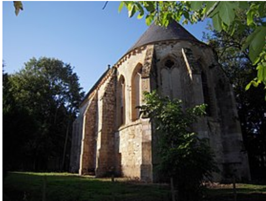
Eglise templière de la Commanderie des Bordes , Ordre du Temple puis de Saint-Jean-de-Jérusalem (à Jussy-le-Chaudrier, 18)
