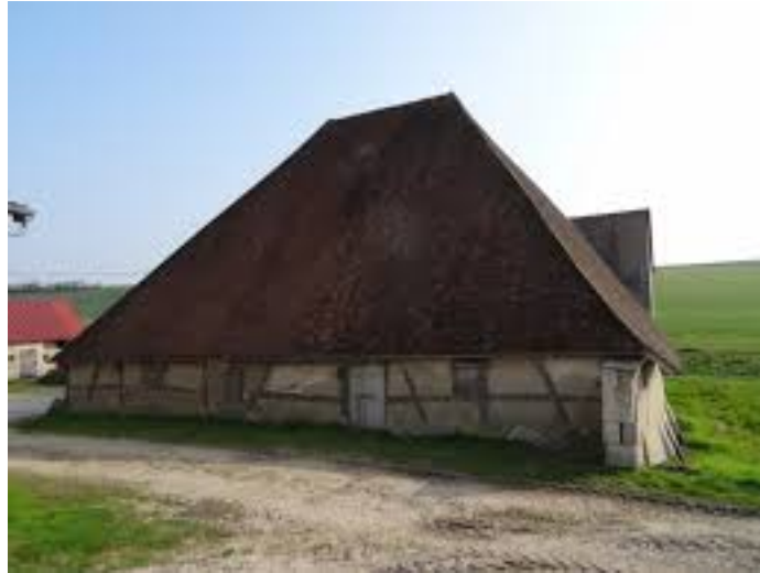
Grange de Fontaine (Pougny)
