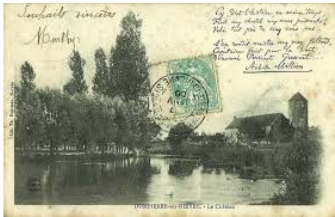
Tour de l'ancien château de Dompierre-sur-Nièvre
