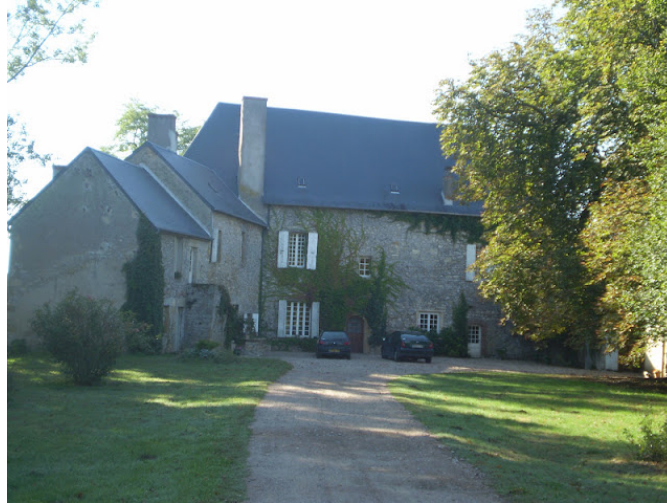
Coulonges (Cercy-la-Tour), maison du Prieur (XVème)
