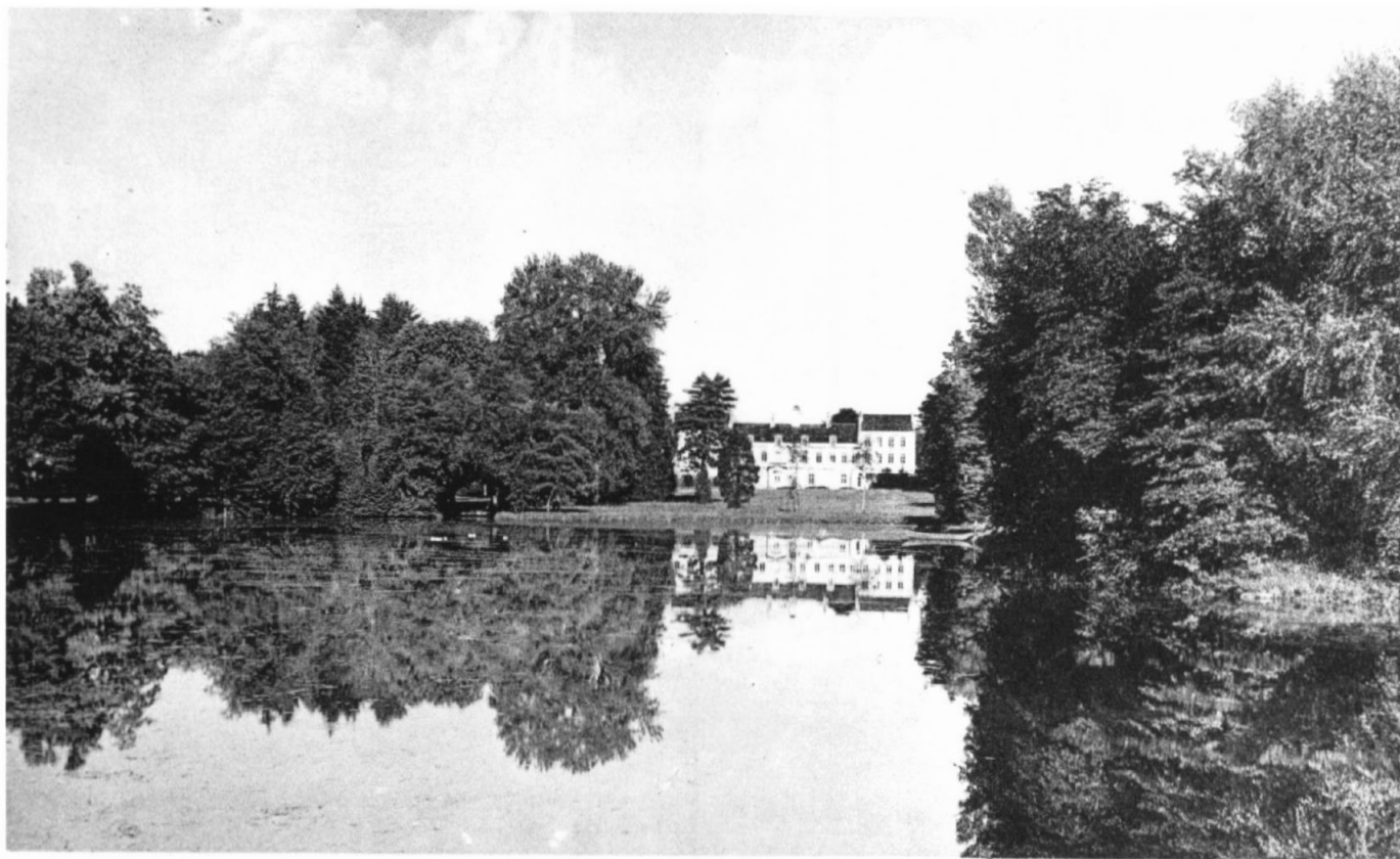
Château du Réconfort - Face Sud
